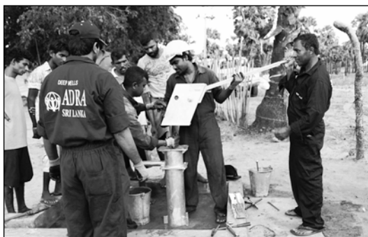
Instalace ruční pumpy
